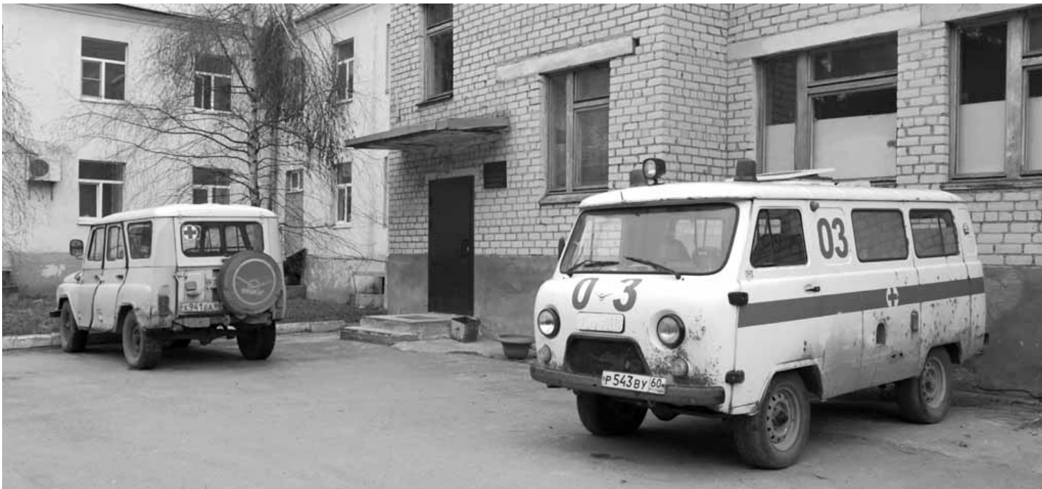
Печорская районная больница отражает все проблемы районного здравоохранения: разрушающиеся здания, дефицит кадров и денег.
